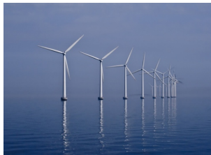
Energie mécanique (vent) se transforme en électricité
